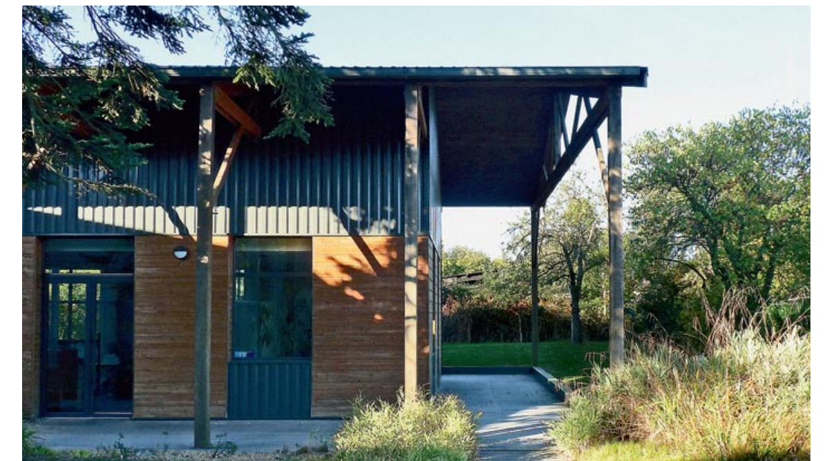
Entreprise de menuiserie, charpente, agencement à Saint-Vincent-des-Landes (44) - Philippe Misériaux, architecte, Source : (Ré)inventer la zone d'activités, CAUE Loire Atlantique
