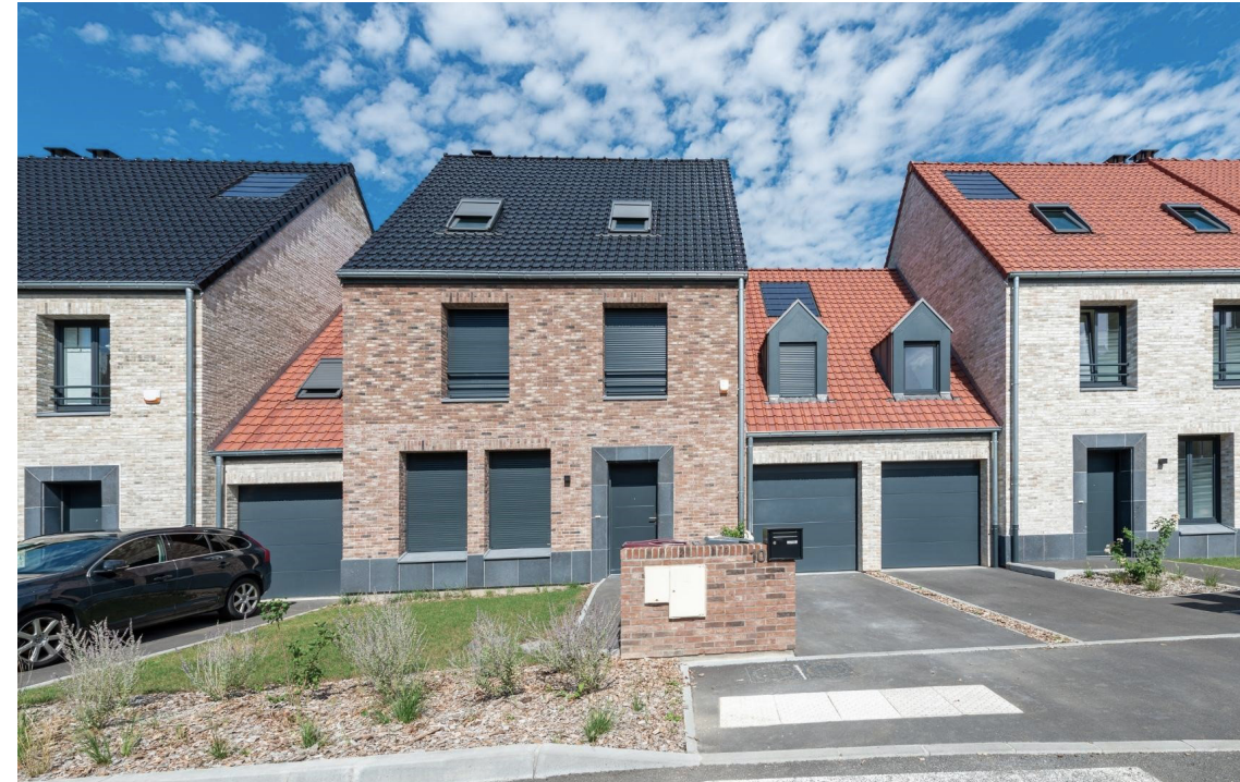
Les terrasses du long champ Construction de 102 logements mixant appartements et maisons Verlinghem, Alain Bossan
