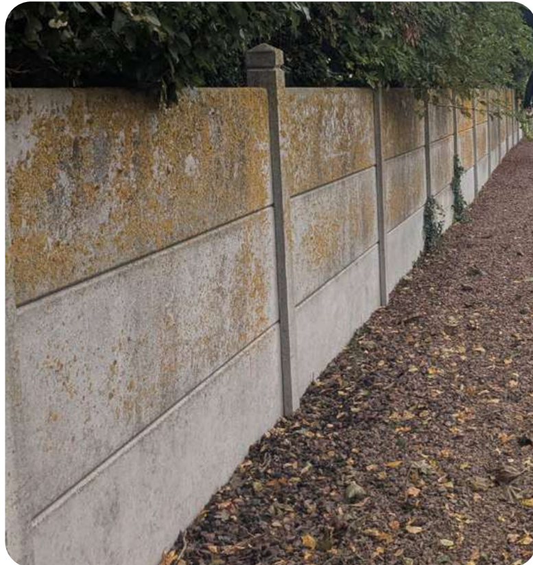
Clôture qui semble en bon état sur \pm 50\text{m}
